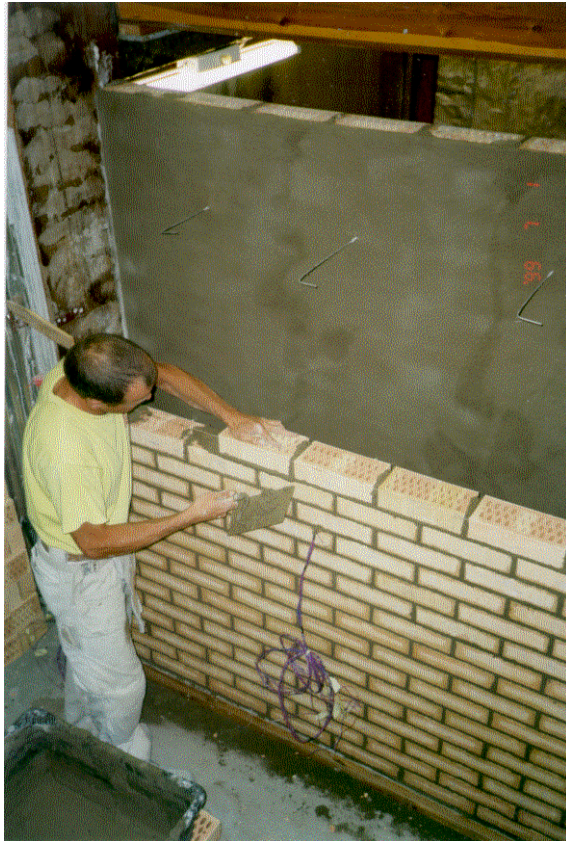
Bild 1. Provmuren byggs upp
